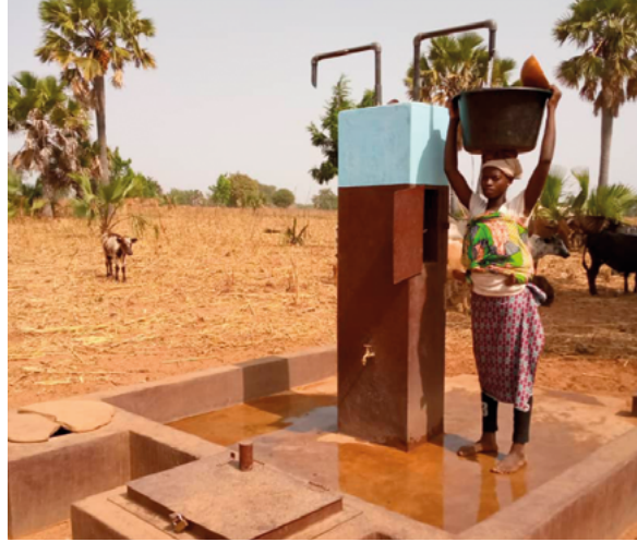
Villageoise tirant de l'eau d'une borne fontaine installée dans le village de Kssankangbane, au Togo (crédit photo: ECM).
